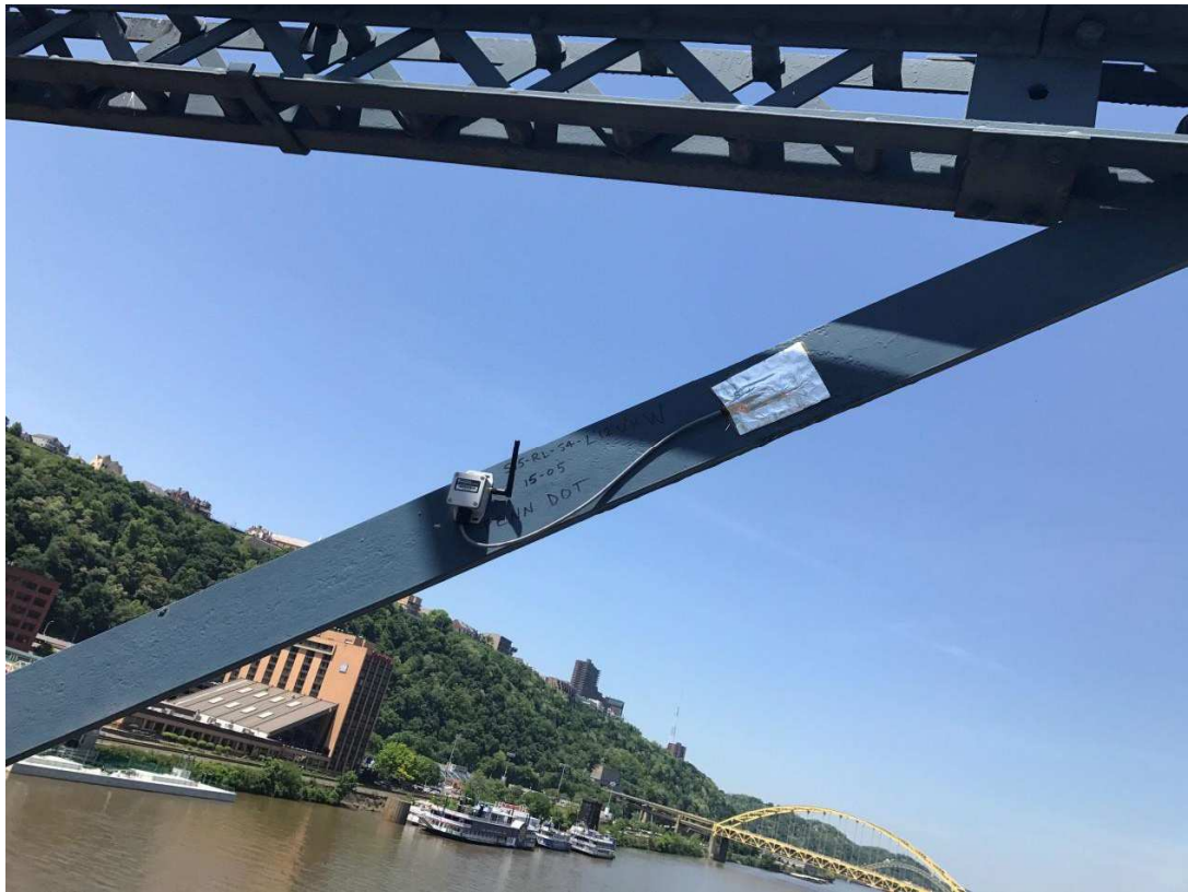
Slika 7: Instalirani merač napreznja na mrežnoj strukturi mosta
