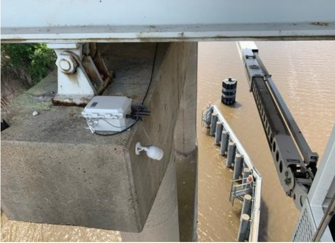
Bežične solarne kamere na mostovima za otkrivanje i praćenje sudara plovila. Kamera snima brod nakon što su bežični akcelometri otkrili udar
