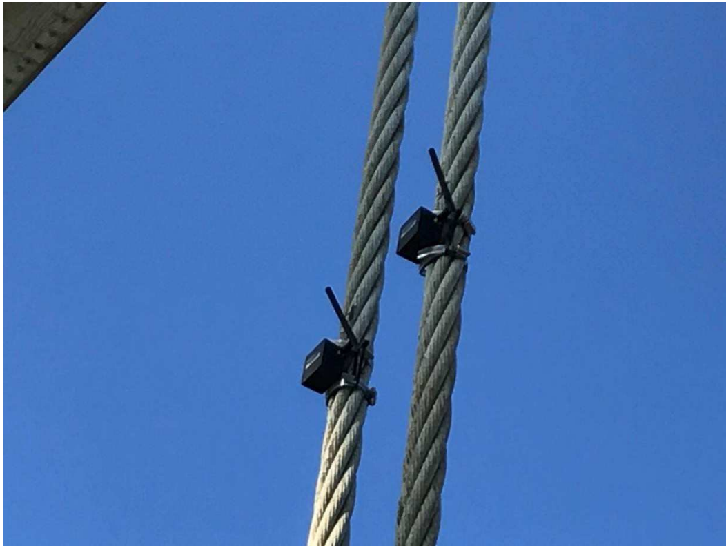
Slika 5: Resensis akcelometerar visokih performansi (HPA) SenSpot™ instaliran na kablovima visećeg mosta
